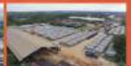
Plant Palembang, Sumatera Selatan
